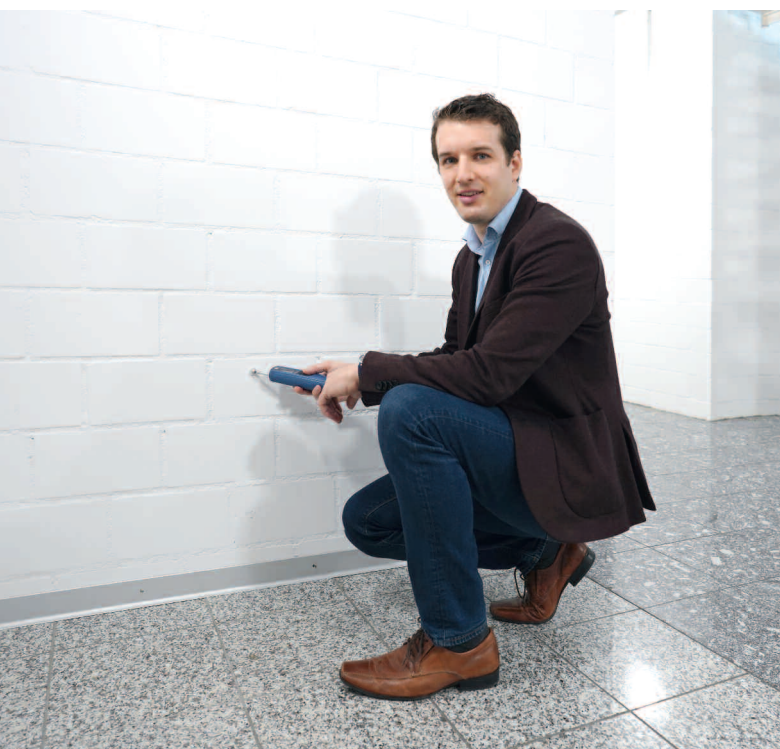
Dimitri Spori, Visana-Schadenspezialist für Sachversicherungen, misst die Feuchtigkeit der Wände nach einem Gebäude-Wasserschadenfall.
